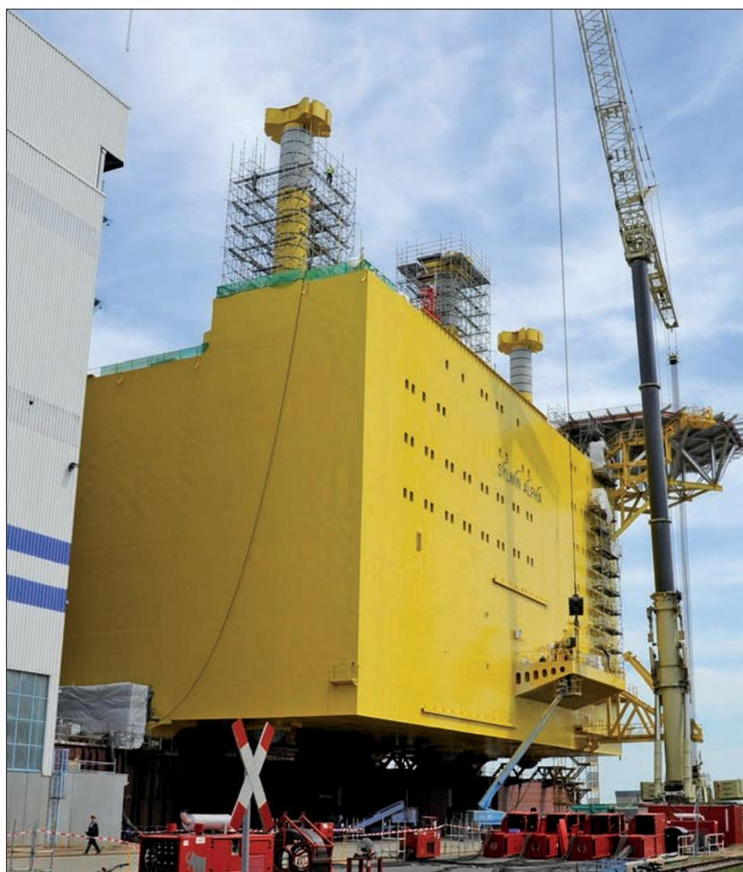
*Bild 1: 26 m hoch: Die Plattform SylWin Alpha kurz vor der Fertigstellung*
