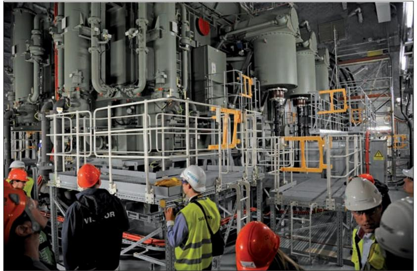
Bild 8: Der 637-MVA-Transformator bringt 500 t auf die Waage
