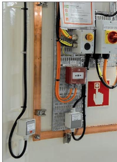
*Bild 9: Kupferschienen stellen den Potentialausgleich sicher*
